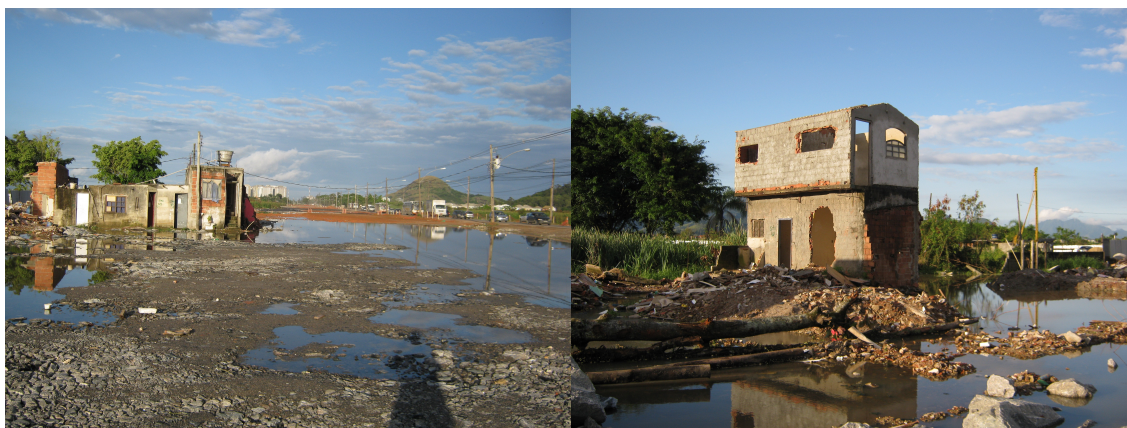
As demolições das casas na Vila Recreio II para a construção da Transoeste
